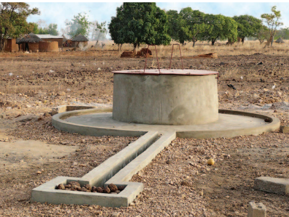
Brunnen müssen sachgerecht angelegt werden mit einem Ablauf für verschüttetes Wasser und einer Abdeckung zum Schutz der Kinder.
