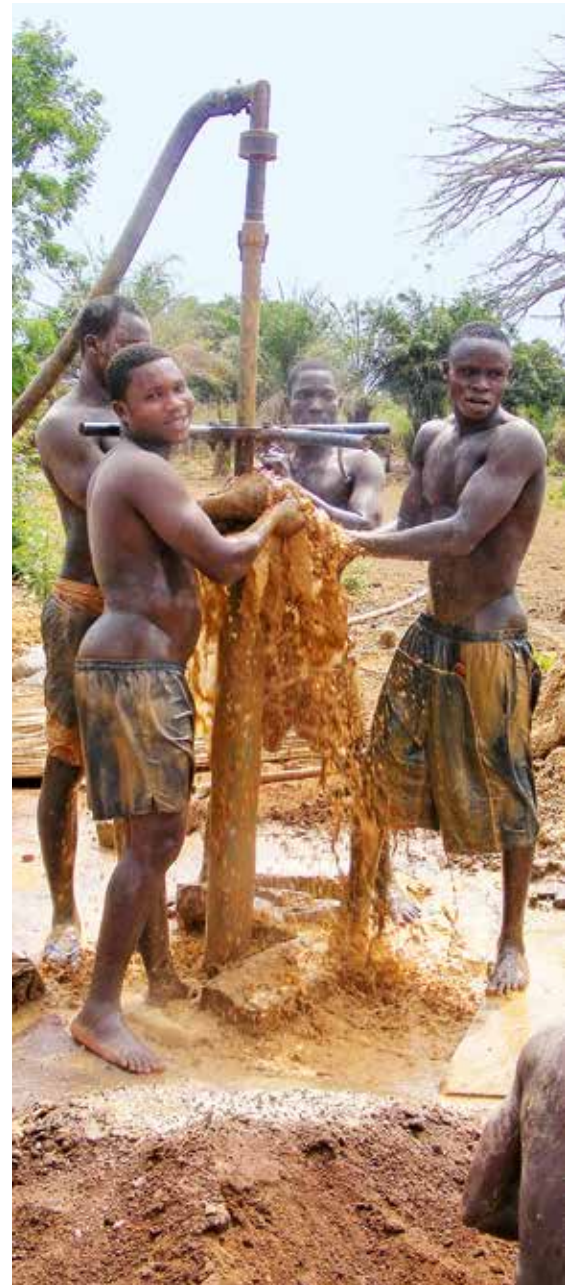
Im letzten Jahr konnte endlich ein Brunnen an der Station gebohrt und so die Versorgung mit Trinkwasser verbessert werden.
