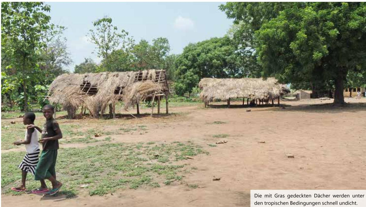
Die mit Gras gedeckten Dächer werden unter den tropischen Bedingungen schnell undicht.
